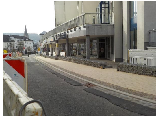
Bauarbeiten im Stadteingang Nord Foto: Sandra Valperz, Stadt Wiehl
