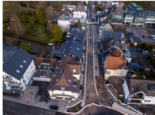
Luftbild von der Baustelle Bahnhofstraße Foto: Tim Vogel (Bird's Vision – Petri & Vogel GbR)
