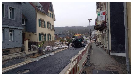
Baustelle Bahnhofstraße Foto: Citymanagement Wiehl
